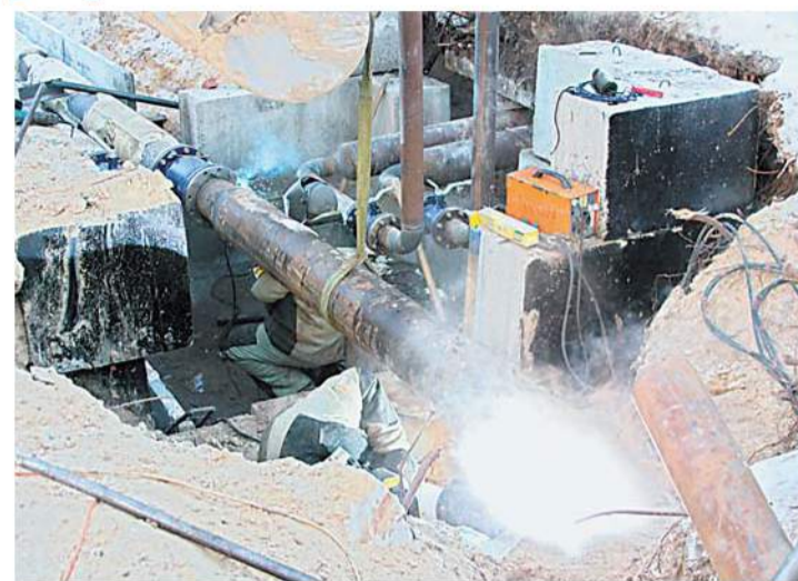
Работы на улице Станиславского завершатся до конца декабря.
