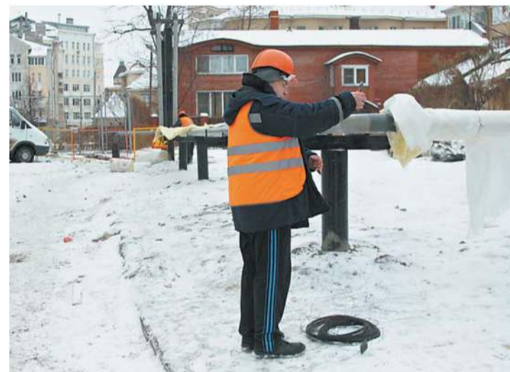
Теплотрассу проложили в кратчайшие сроки.
